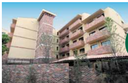
ロングライフ 高槻I号館
