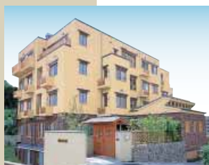
ONGLIFE Senriyama (Exterior) ロングライフ千里山(外観)
